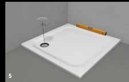
5 INSERIMENTO DEL PIATTO DOCCIA E COLLEGAMENTO DELLO SCARICO
